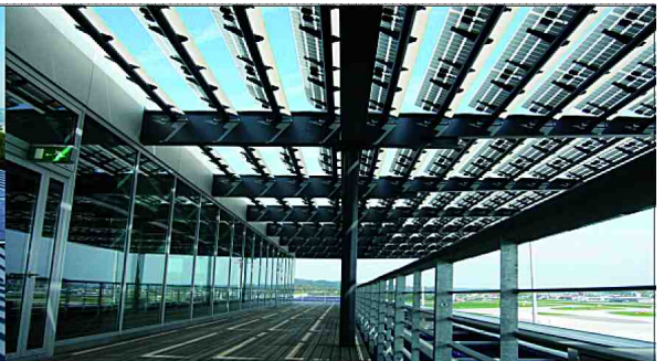
275 kWp Dock E, Flughafen Zürich
