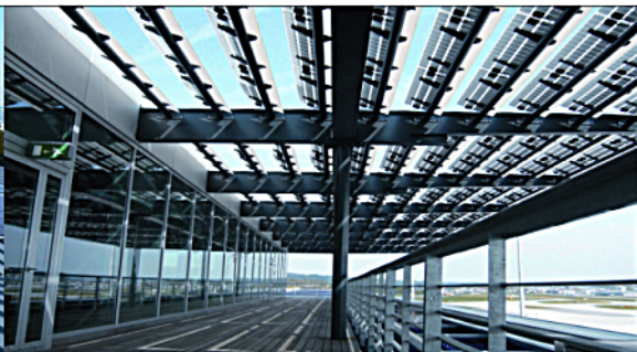
275 kWp Dock E, Flughafen Zürich
