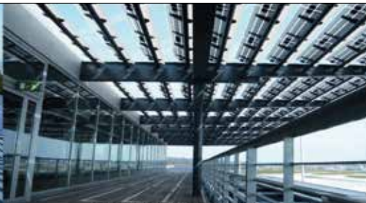
275 kWp Dock E, Flughafen Zürich
